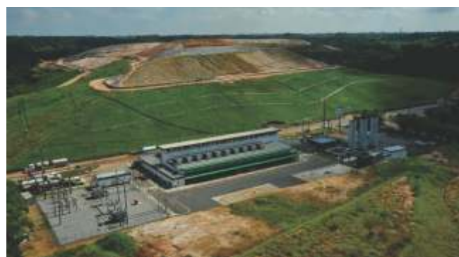
Aterro e usina termelétrica - Termoverde Salvador
